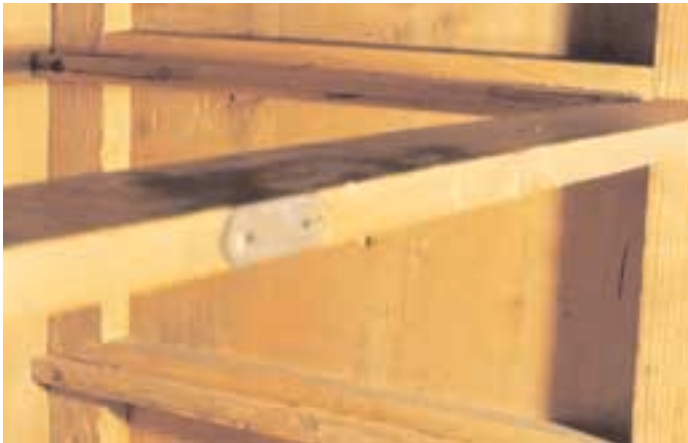
Abb. 14 Endzustand – Laufleisten Mitte rechts
